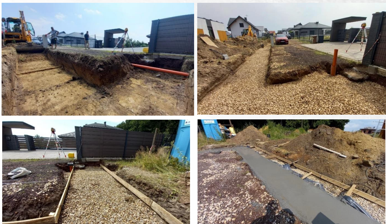
Obr. 2. Jednotlivé fázy zhotovenia základu plotového múru (výkop, plnenie kamenivom, príprava debnenia, zalatie betónom).
