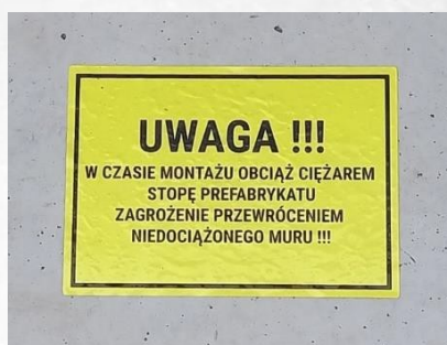
Obr. 4. Samolepka na pätke steny informujúca o nutnosti zaťaženia.
