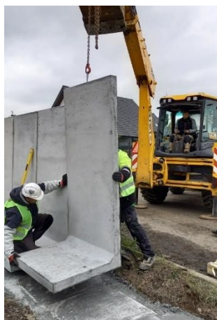
Obr. 1. Začiatok pokládky plotových múrov na pripravený podklad.
