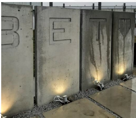
Obr. 6. Vľavo steny napustené impregnačným prípravkom LOVBET, vpravo bez impregnácie
