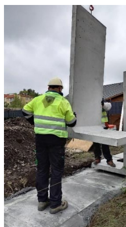
Obr. 1. Začiatok pokládky plotových múrov na pripravený podklad.
