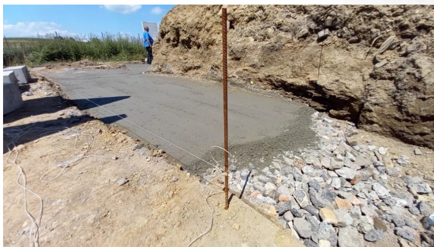
Obr. 3b. Vyrovnávacia vrstva
