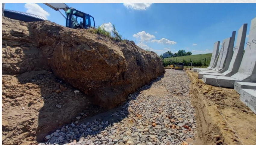
Obr. 3a. Základná vrstva z kameniva
