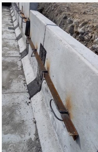
Obr. 6a; 6b. Ochrana proti "zaklíčovaniu" spojením oporných múrov výstužnými tyčami s priemerom Ø 16 mm alebo uholníkom 50x50x5 - pred aplikáciou antikorozného prostriedku.
