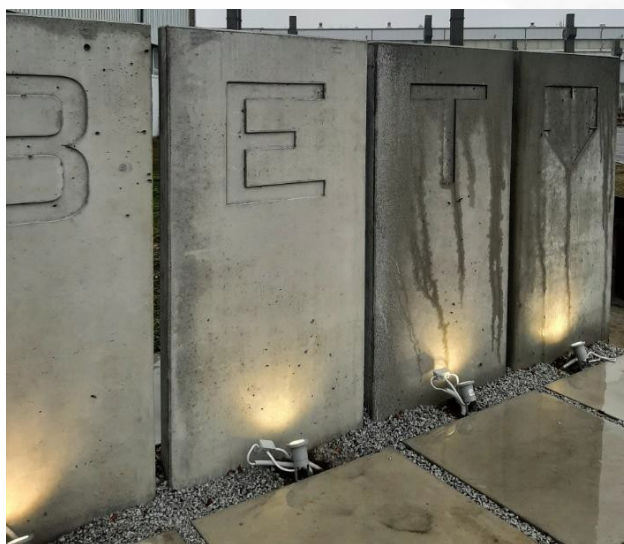
Obr. 9. Vľavo steny impregnované, vpravo bez impregnácie
