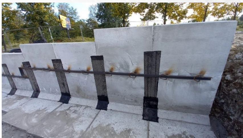
Obr. 4. Pás izolačného materiálu na spojoch oporných stien na vnútornej strane.
